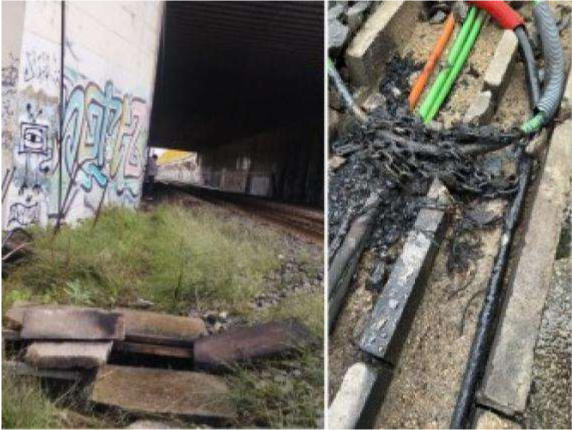
Alcuni dei cavi bruciati sulle linee dell'Alta velocità
