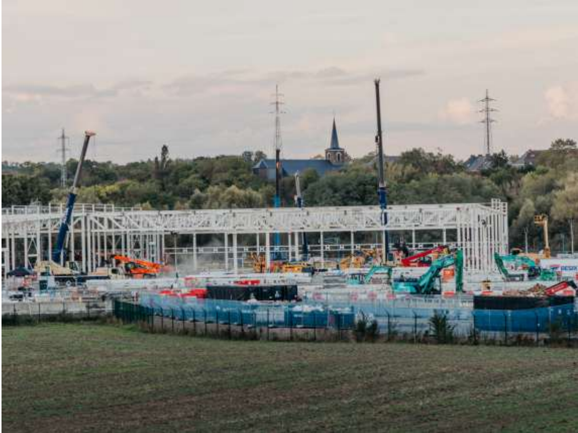
Il cantiere di un data center a Farciennes, in Belgio (Kevin Faingnaert)
