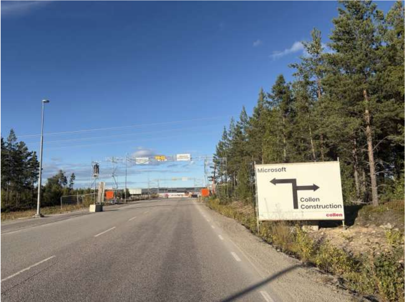
L'area del data center in costruzione a Gävle, in Svezia (Mei-Ling McNamara)
