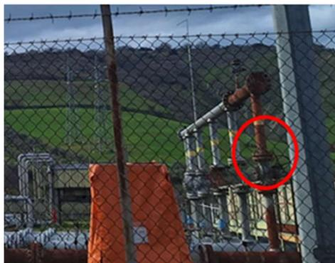
Il primo dei tre elementi monitorati, per una durata di 4 minuti, posto ad una distanza di circa 7 metri dallo strumento e con un vento basso, le emissioni hanno fatto registrare una media di 177 ppm\*m con un range tra 101 e 445 ppm\*m. In questo caso i valori di misura validi sono stati 57. Anche in questo caso, lo stato di conservazione dell'impianto e i valori del monitoraggio effettuato suggeriscono verifiche e controlli per evitare che si registrino ulteriori emissioni.
