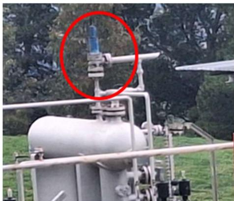
Il secondo elemento preso in considerazione da Legambiente è stato l'insieme di flange evidenziate nell'immagine e poste a circa 35 metri di distanza dallo strumento. Anche in questo caso il monitoraggio ha avuto una durata di 4 minuti in presenza di un vento moderato, con valori fino a 1.458 ppm\*m e una media di 731 ppm\*m. In questo caso sono stati 202 i punti di misura validi.
