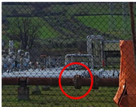
Anche la seconda flangia monitorata per 4 minuti e posta ad una distanza di 7 metri, sono stati registrati valori medi pari a 1.443 ppm\*m, con valori da 100 fino a 9.182 ppm\*m. In questo caso sono stati 36 i punti di misura validi.
