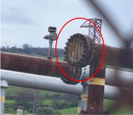
Presso il terzo elemento monitorato, sempre per 4 minuti e posto ad una distanza di 16 metri, sono state rilevate emissioni pari a una media di 1.166 ppm\*m - forse proprio collegate allo stato di cura - con un range di valori tra 103 e 11.460 ppm\*m. I punti di misura validi erano 181.
