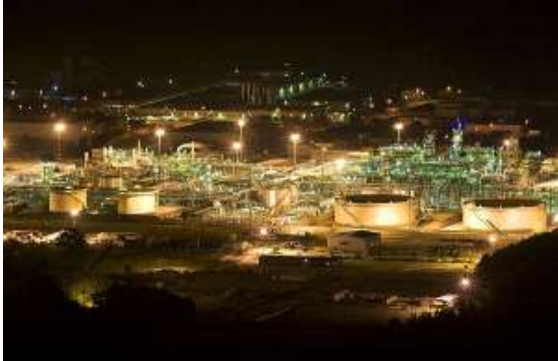
Centro Olio Val D'Agri (Viggiano - Basilicata)
