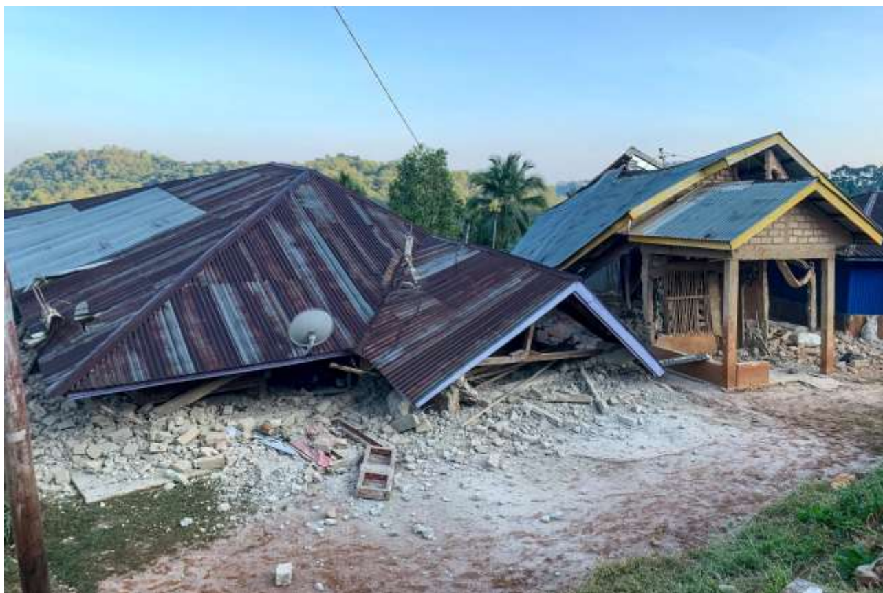
Abitazioni crollate per il terremoto (Afp)
