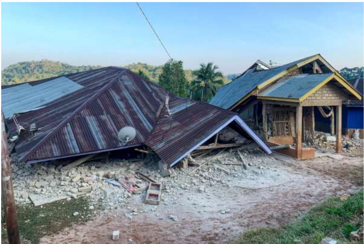
Abitazioni crollate per il terremoto (Afp)
